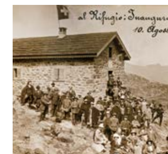
Steinhütten der ersten und zweiten Generation: Rottalhütte, erbaut 1872 (oben) und Capanna Campo Tencia, erbaut 1912 (unten).
