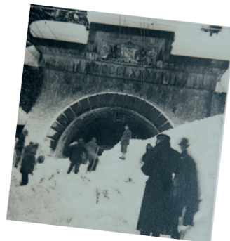
Der Arlberg-Eisenbahntunnel nach einem Lawinenabgang.
