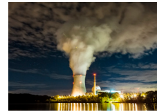
S. 169 Kernkraftwerk Leibstadt, 28. Mai 2011.
