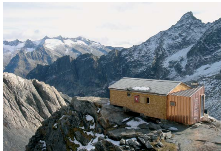
Die im Jahre 2005 umgebaute Gruebenhütte bietet 16-20 Schlaf- und Sitzplätze für gemütliche Abende. Das alte Biwak wurde in ein Boulderbiwak umgewandelt - trockene Griffe für nasse Tage.
